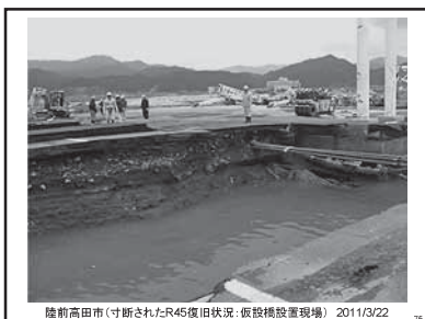
陸前高田市 (寸断されたR45復旧状況:仮設橋設置現場) 2011/3/22 75
