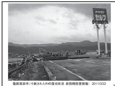
陸前高田市 (寸断されたR45復旧状況:仮設橋設置現場) 2011/3/22 74
