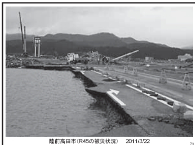
陸前高田市 (R45の被災状況) 2011/3/22 73
