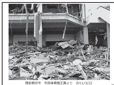
陸前高田市 市民体育館正面より 2011/3/22 80
