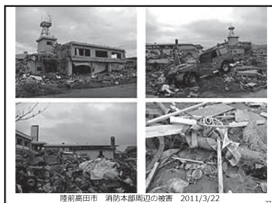
陸前高田市 消防本部周辺の被害 2011/3/22 77
