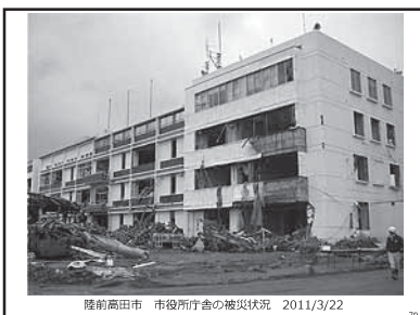
陸前高田市 市役所庁舎の被災状況 2011/3/22 79
