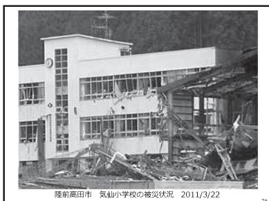
陸前高田市 気仙小学校の被災状況 2011/3/22 78
