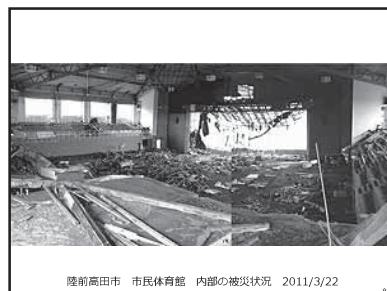
陸前高田市 市民体育館 内部の被災状況 2011/3/22 82
