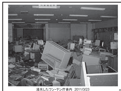
浸水したワンテン庁舎内 2011/3/23 46
